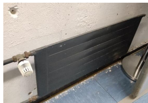
Abbildung 13: Glatte wandige Flachheizkörper
