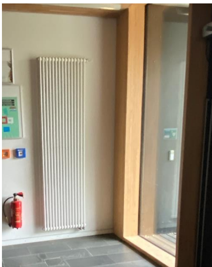
Abbildung 20: Stahlrohr radiator im Neubau
