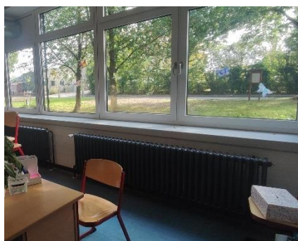
Abbildung 14: Guss-Gliederheizkörper
